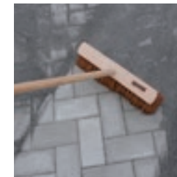
Sand einfügen und von der Oberfläche abfegen
