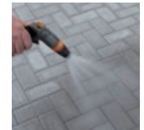
Fläche ausreichend wässern, Nachbehandlung beachten
